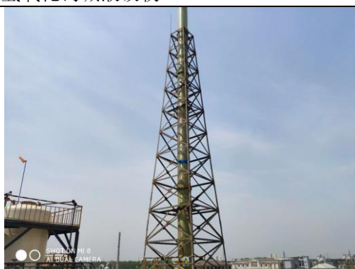
废气输送管线及排气筒
