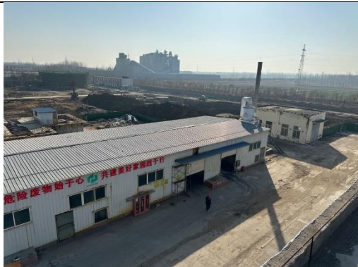
危险废物贮存场所外部
