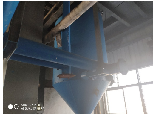
氯氰基苯装置投料配套除尘器
